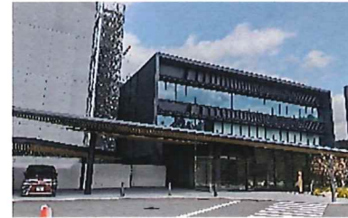
トヨタ テクニカルセンター 下山テストコース施設 (愛知県豊田市)
