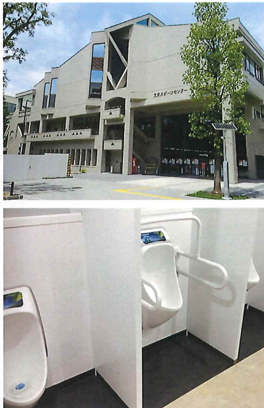
文京スポーツセンター 東京都文京区
