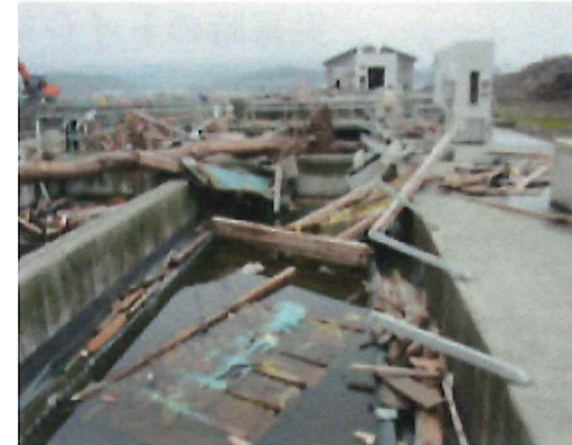
被災した汚水処理施設
