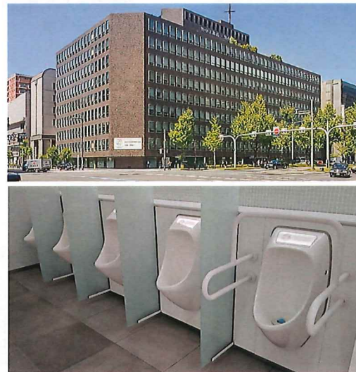
竹中工務店 御堂ビル 大阪府大阪市
