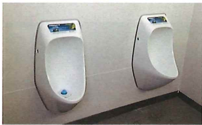
水洗小便器からの取り換え
