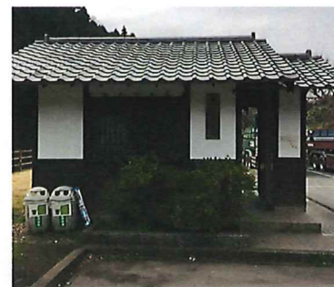
龍門の滝 駐車場 栃木県那須烏山市
